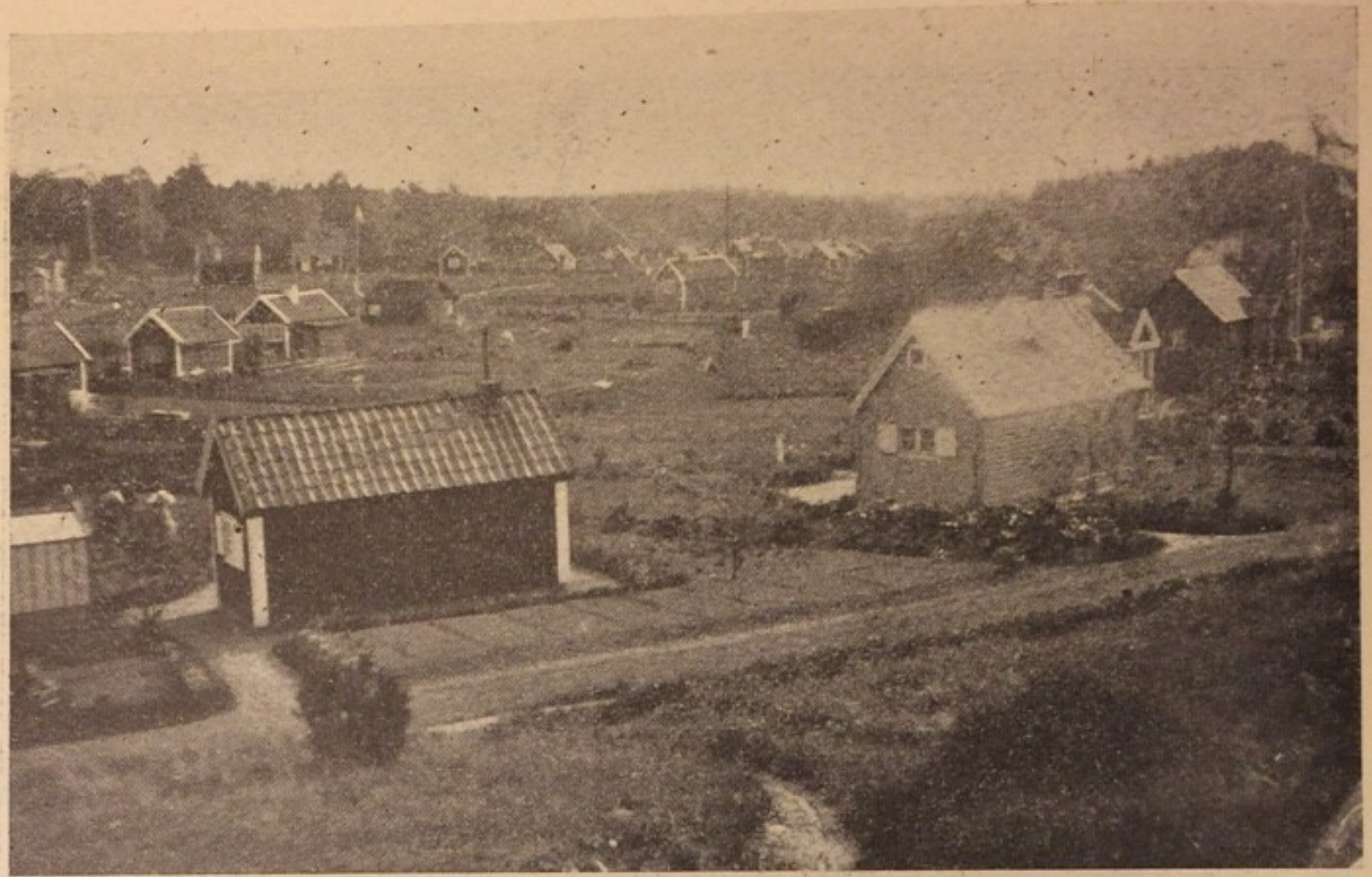
Området sett från Riksby mot sydväst.
